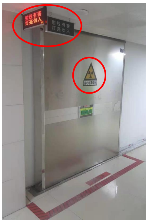
图 4-2 后装治疗室防护门
